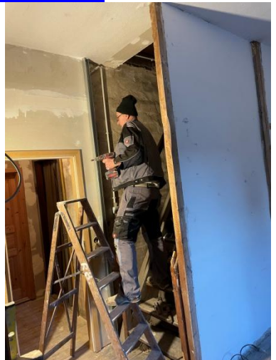
Einbau der Tür zum Spitzboden
